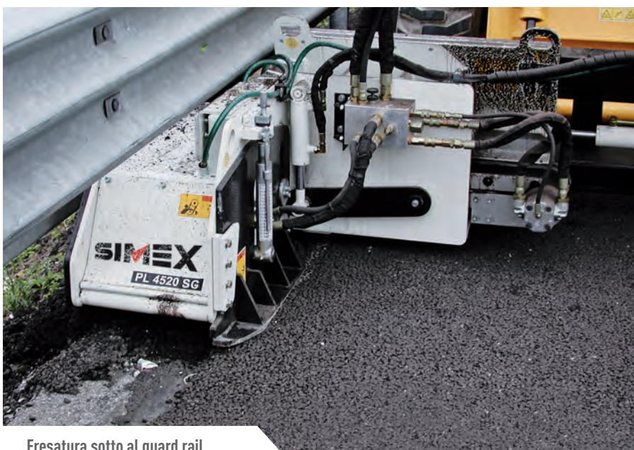
Fresatura sotto al guard rail
