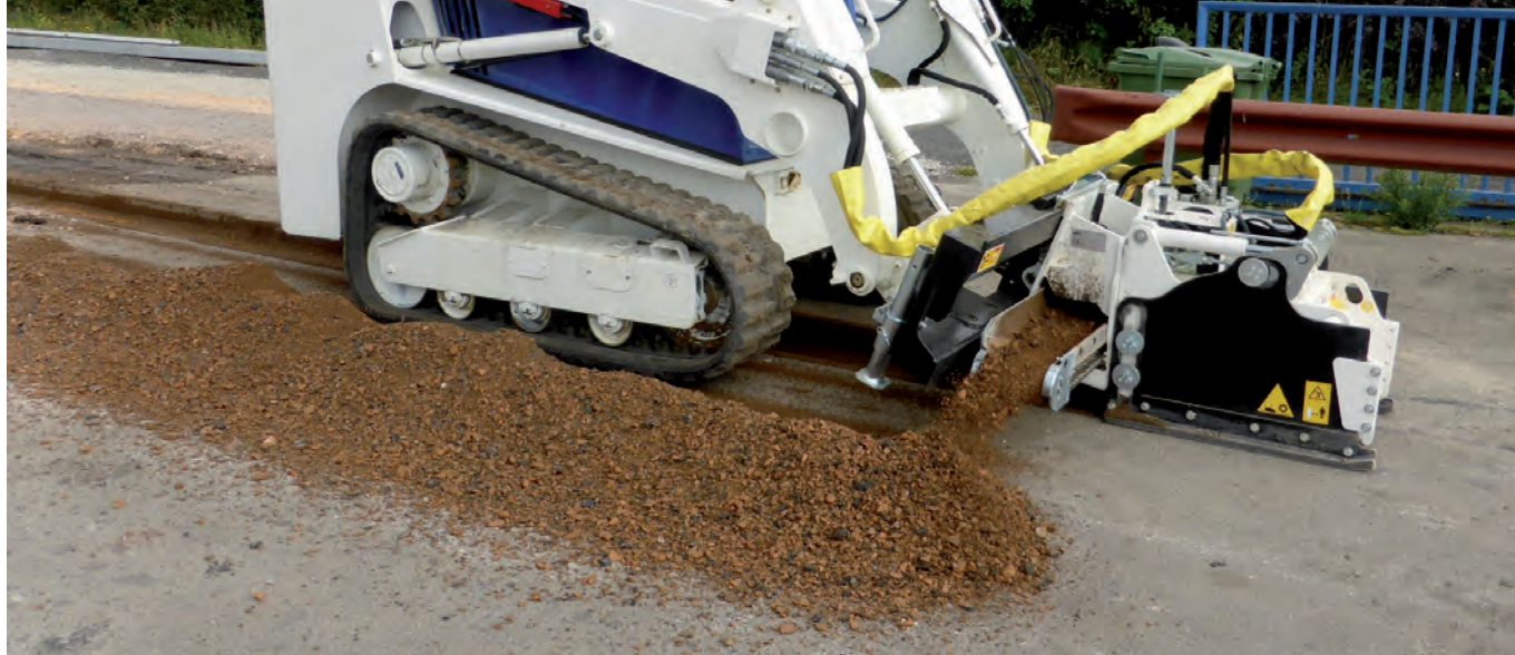
Nastro trasportatore - lo scavo rimane vuoto ed il materiale scaricato a lato
