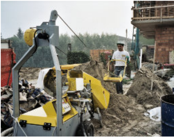
L'adozione della pala raschiante garantisce alte rese produttive. The use of the skid enables higher productivity.
